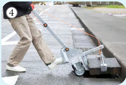
テコの原理を利用して ハンドル部を押し下げる。
