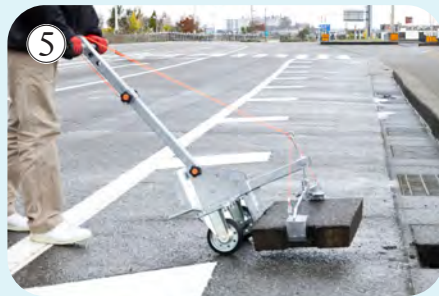
側溝ふたをつかんだまま 安全な場所に置く。
